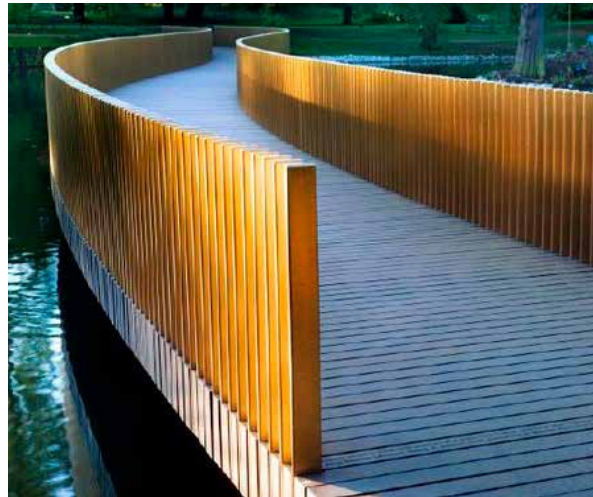
Rækværk med lysspil - Footbridge Kew Gardens, London
