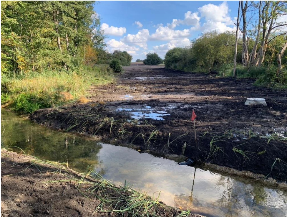
Figur 5 Udløb af ny rørledning i Lindved Å
