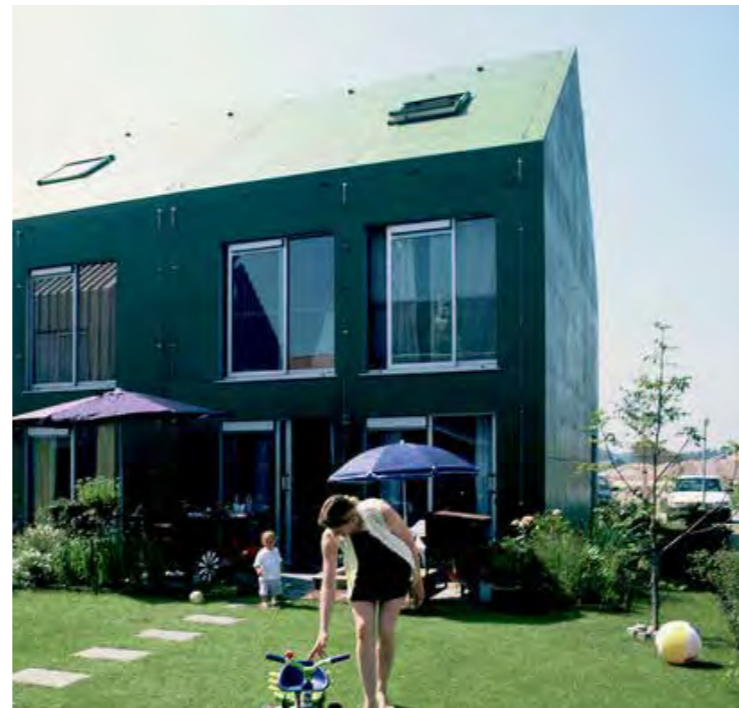
Tag og facade i farvet tegl.
