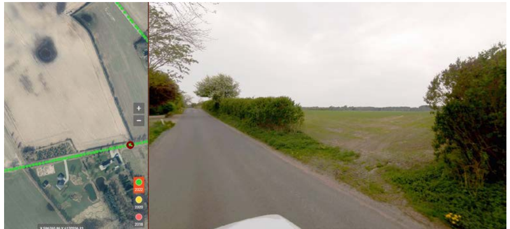
Figur 4-44 Foto af eksisterende digegennembrud ved Sallingevej, der vil blive anvendt som adgangsvej til solcelleanlægget. COWI Gadefoto, 2022.
