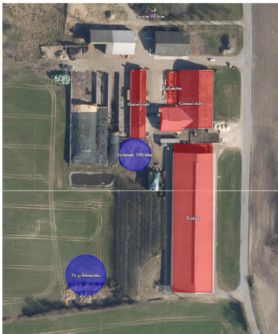
Figur 1. Staldafsnit og opbevaringsanlæg på Sølvbjergvej 35
