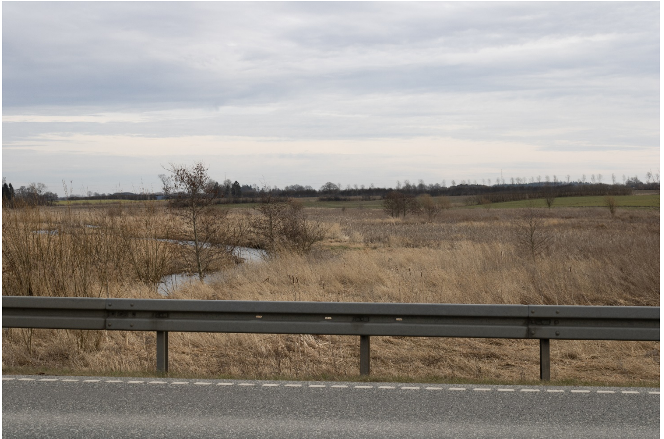
Figur 4-35 Fotopunkt 6 – Visualisering uden beplantning. Afstanden er ca. 1.100 m. Anlægget med ny beplantning ligger bag eksisterende terræn, bebyggelse og beplantning, og kan næsten ikke ses fra dette punkt.
