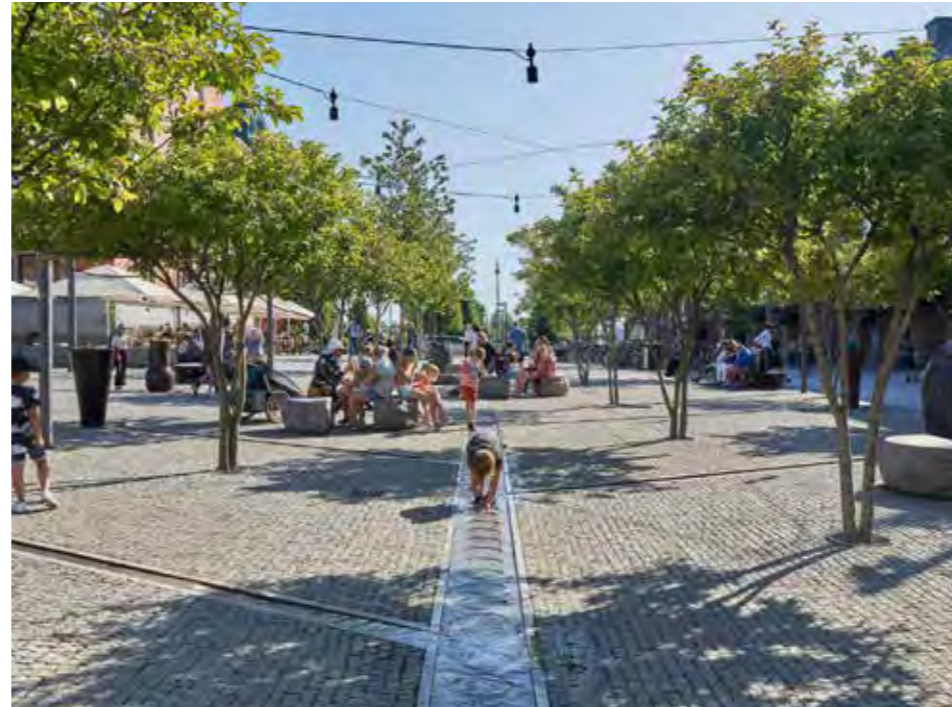
Håndteringen af regnvand sker ad render bygget i tegl dækket af en rist hvor der er behov for passage.
